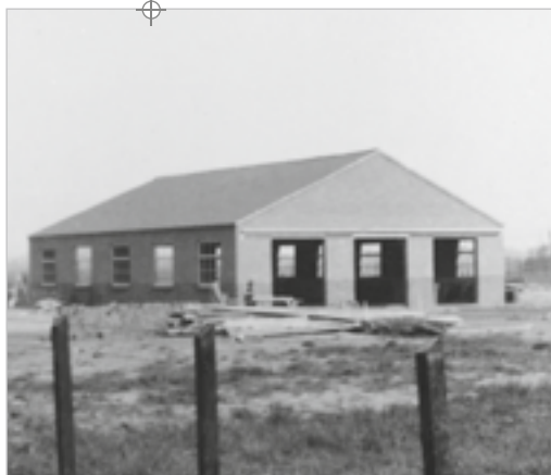
DE NIEUWE SCHAVERIJ AAN DE GEERSEWEG, GEBOUWD IN 1943.
